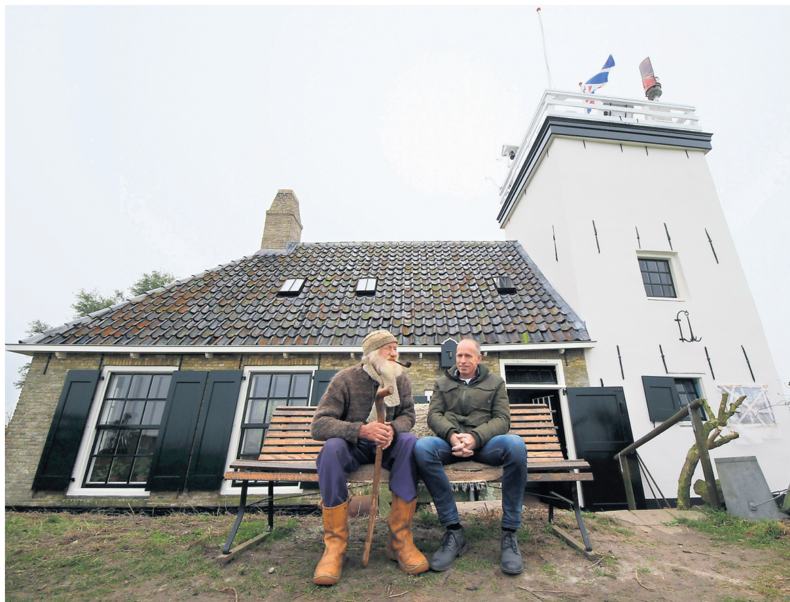
Reid de Jong (links) en Harm Haitsma bespreken het resultaat van de restauratie van Tointsje Leech. FOTO SIMON BLEEKER
