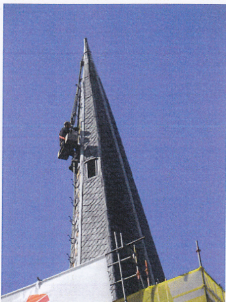
Luxemburger Robby Schiltz brengt zittend op z'n bootsmanstoeltje klimhaken aan op de torenspits. (foto: U/J)
