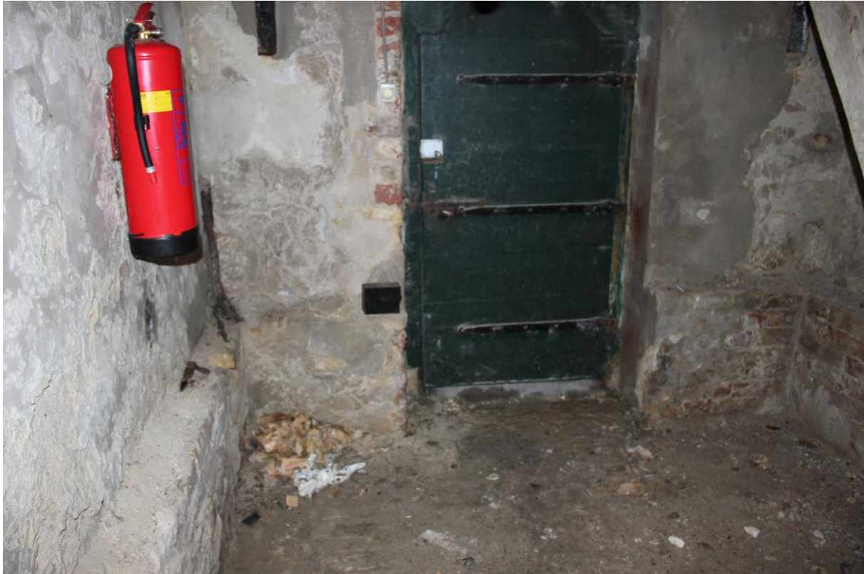
Foto 7. De ingang van de kerktoeren. Op de muren zijn meerdere lagen cementpleister aangetroffen. De vloer bestaat uit een vlijlaag van Friese geeltjes.
