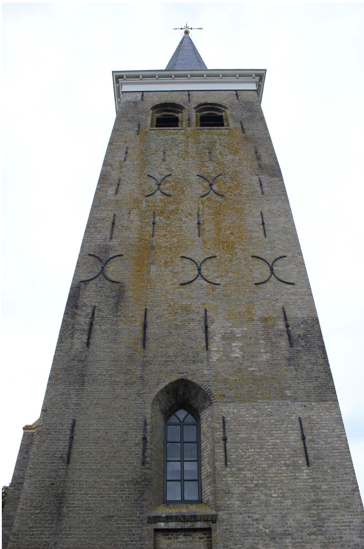
Foto 4. De westgevel van de toren. De herstellingen uit 1984 zijn nog duidelijk zichtbaar. Deze gevel heeft vijf rondgebogen ankers.
