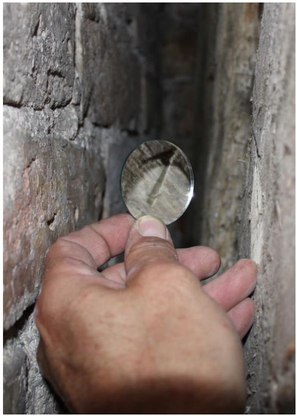
Foto 28. De letter A in het spiegelbeeld. Dit merk bevindt zich op de dekbalk aan de muurzijde en is alleen met een spiegel te vinden. Ook deze is duidelijk gehakt.
