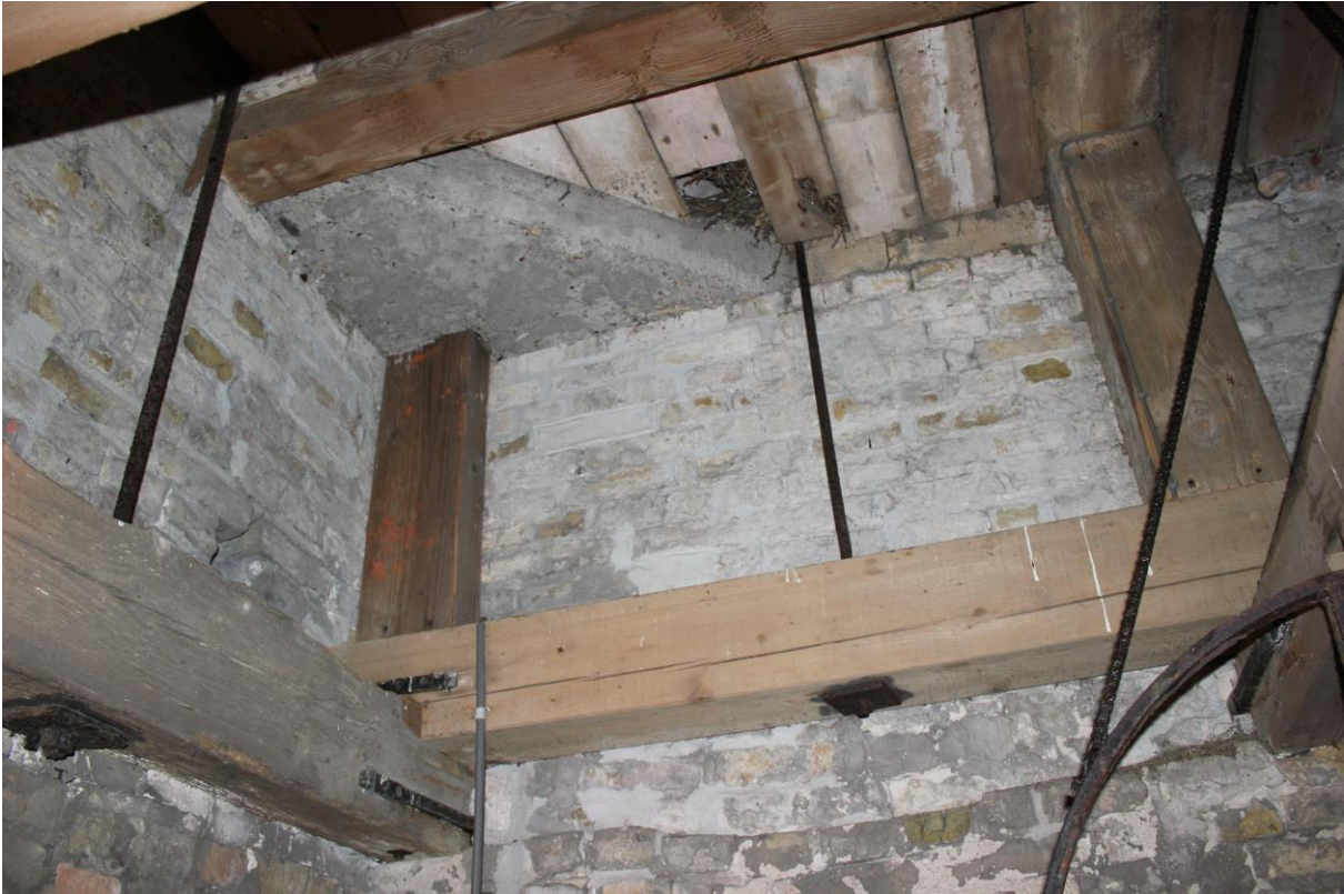
Foto 30. De ringbalken boven in de toren boven de klokkenzolder. De draadankers zijn door de balken gemonteerd en aan de hoekkepers van de spits bevestigd. In de hoek is een deel van het betonnen tafelfment te zien. Dit herstelde ringbalken met de korte staanders zijn de herstellingen uit 1984.
