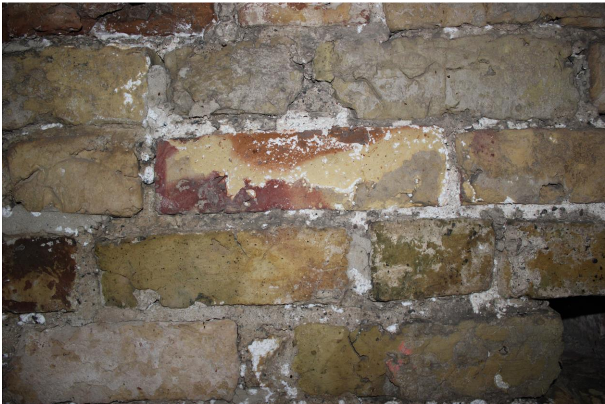
Foto 14 . Een deel van het muurwerk op de tweede verdiepingsvloer. In het midden is een gele baksteen herkenbaar met een rode bakhuid.
