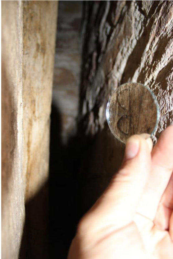
Foto 27. De letter B in het spiegelbeeld. Dit merk bevindt zich op de dekbalk en is alleen met een spiegel te vinden. Deze is duidelijk gehakt.
