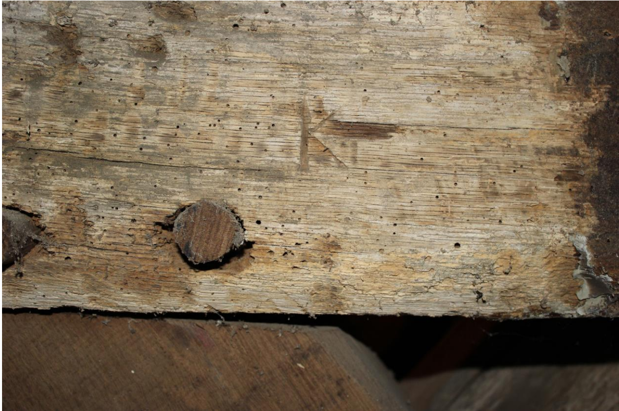
Foto 25. De letter K in een van de dekbalken die zich op de derde verdieping bevindt. Deze is duidelijk gehakt.
