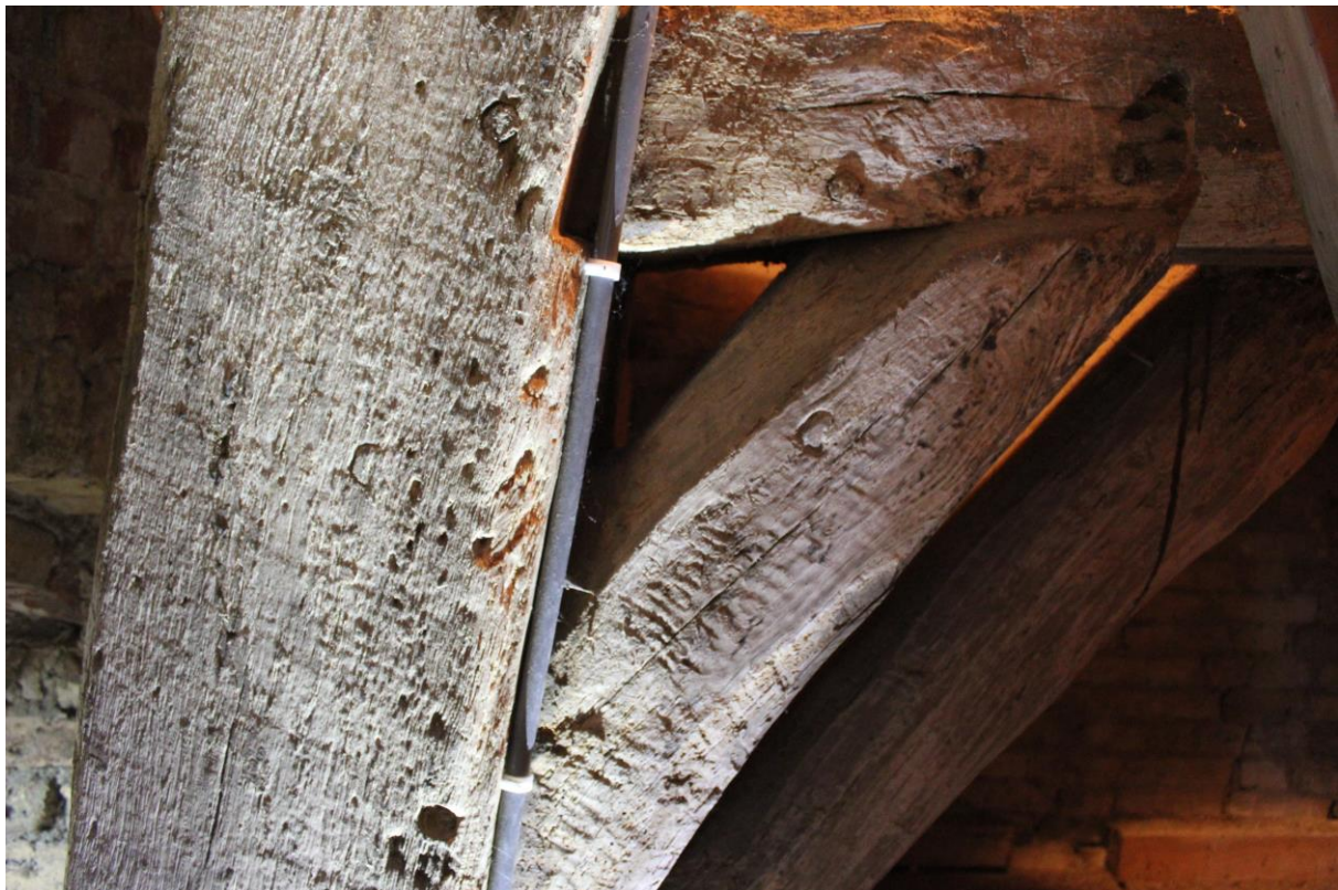
Foto 26. De letter C in een van de dekbalken en in het korbbeel. Deze lijken gehakt.
