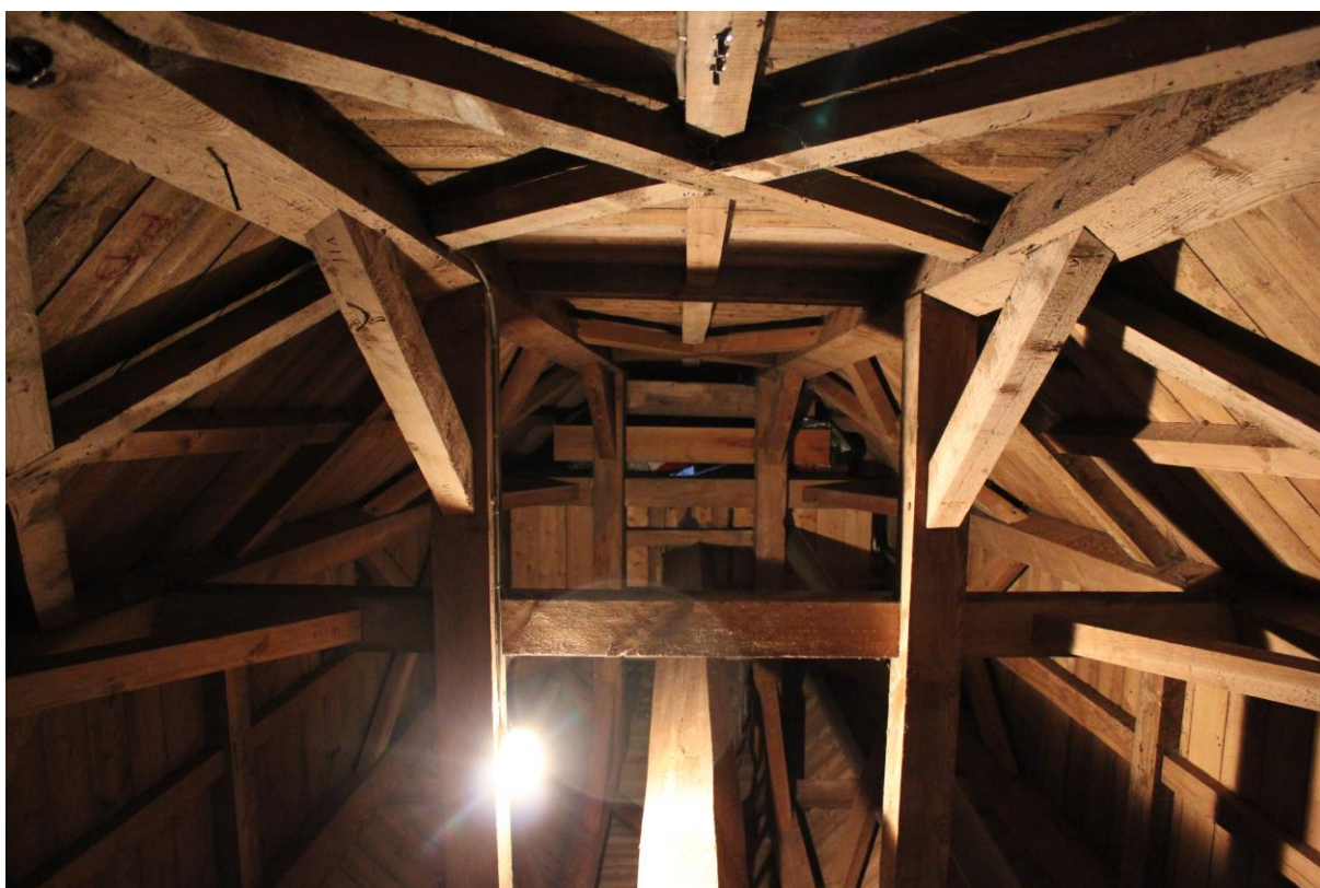
Foto 33. De torenspits van onderen gefotografeerd. Links en rechts zijn op de korbelen de gehakte telmerken zichtbaar. Rechts VI en Links VII. In het midden is de gedraaide koningsstijl te zien.
