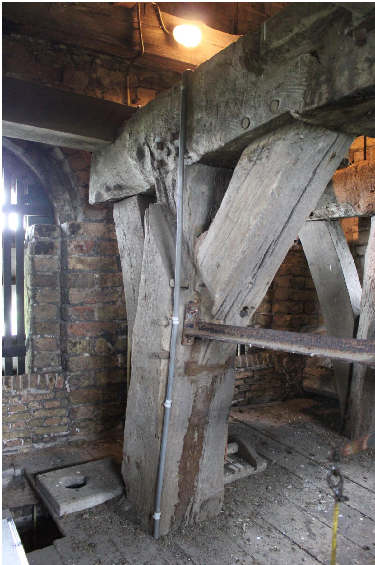
Foto 19. Het bovenste deel van de klokkenstoel op de vierde verdieping. De klokkenzolder. In beeld een van de staanders van het middelste staanderstel. Links en rechts van de staander zijn de forse korbelen zichtbaar die onder de dekbalk zitten. Op het uiteinde van de dekbalk is een koppelbalk gemonteerd die de drie staanderstellen verbindt. Er is flink wat hout verdwenen van het korbeel en de staander. Het is de vraag waarom dit is gebeurd. Op de achtergrond is in de dekbalk een R als merk herkenbaar. Op deze foto is goed te zien dat de onderzijde van de galmgaten zijn verhoogd.
