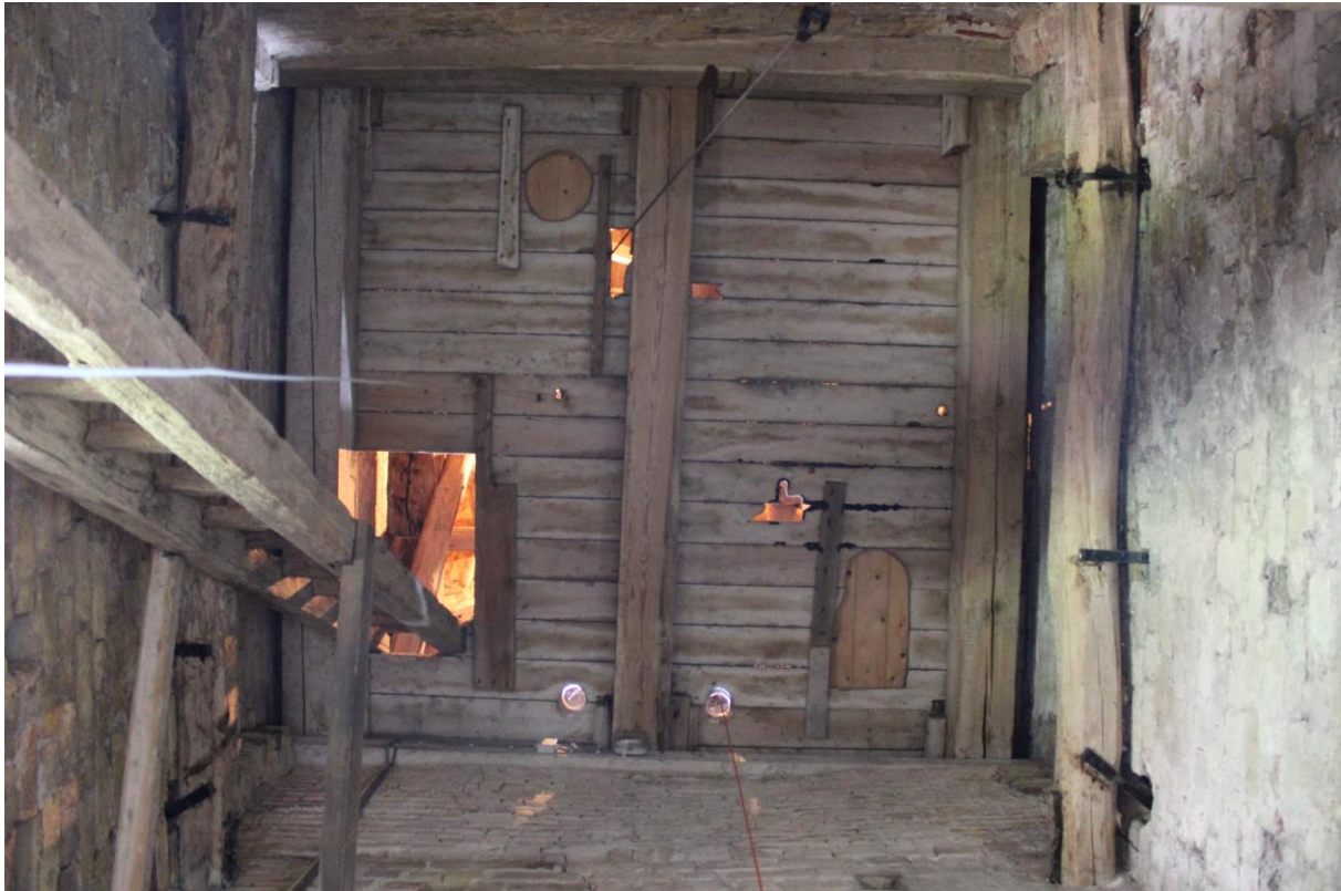
Foto 13 . De onderzijde van de derde verdiepingsvloer gezien vanaf de tweede verdieping.
