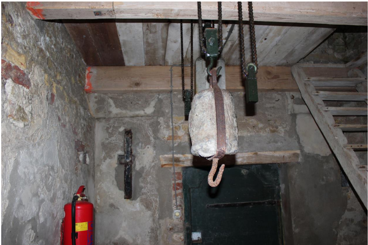
Foto 8. Het plafond van de begane grond in de kerktoeren. De balklaag is een herstelling uit waarschijnlijk 1984. In het midden van de foto hangen de gewichten voor het uurwerk. Rechts in beeld de trap naar de eerste vloer.
