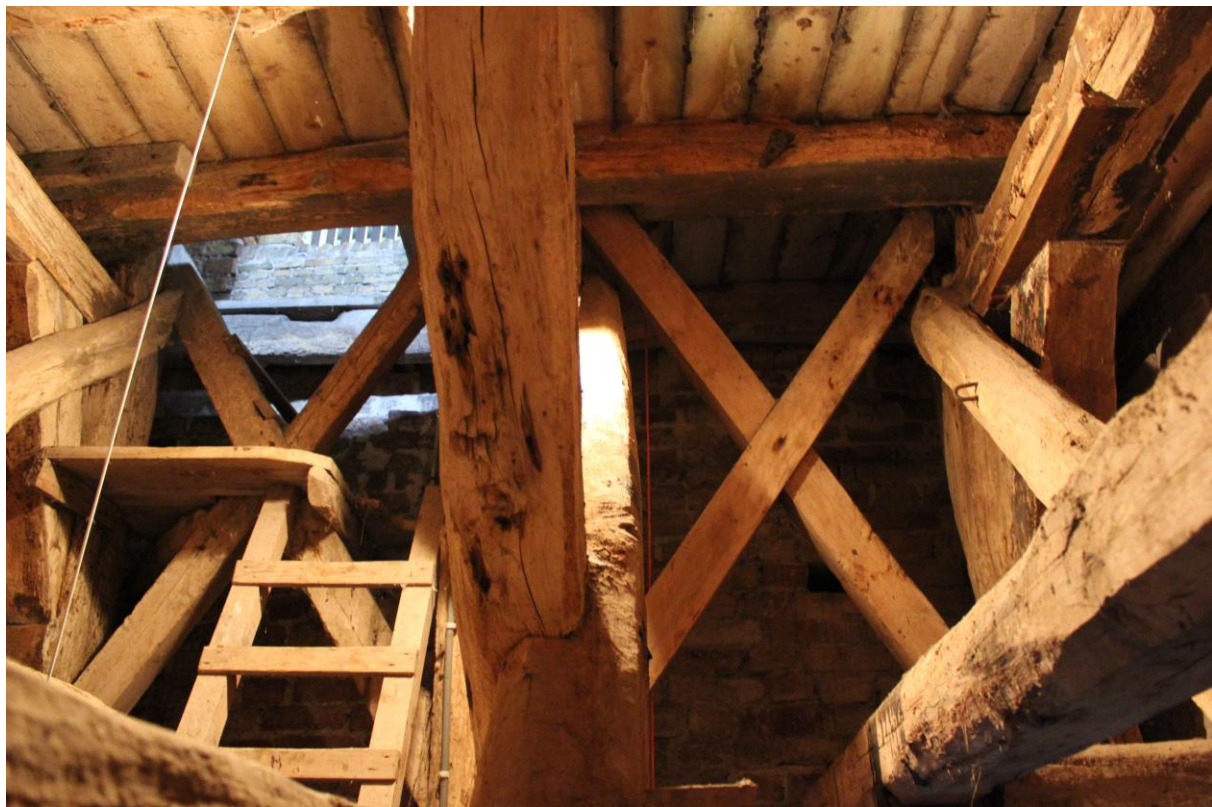
Foto 16 . Een deel van de klokkenstoel op de derde verdieping. Links en rechts zijn de korbelen en dekbalken te zien. Daarop gemonteerd met taaije nagels grenenhouten schoren. In het midden een andereaskruis in het middelste staanderstel. Op de achtergrond twee andereaskruizen die de staanderstellen onderling stabiel houden. Links het rapje met plateau naar de klokkenzolder.
