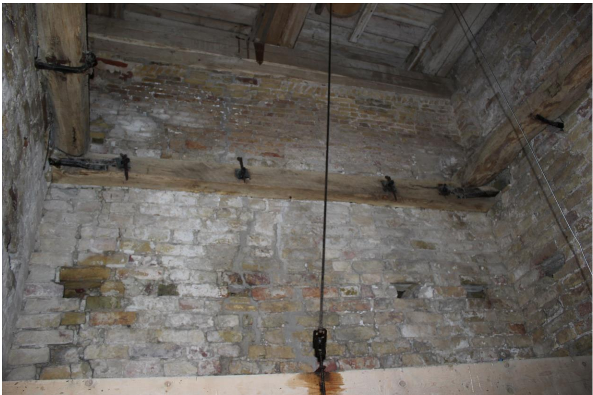
Foto 12 . Een deel van het muurwerk op de tweede verdiegingsvloer. Duidelijk zichtbaar zijn de kortelinggaten, de ringbalken met daar in de muurankers en geheel bovenin een stroomlaag onder de in de muur opgelegde balk.
