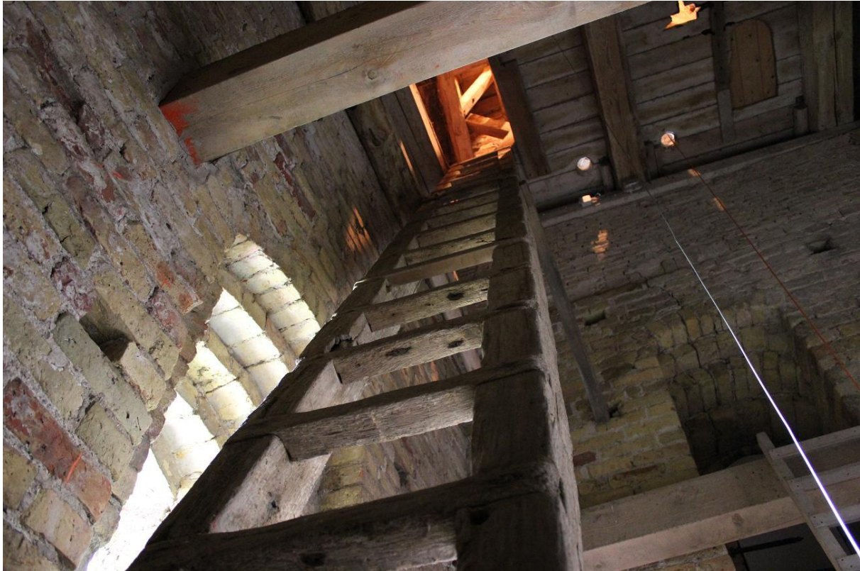
Foto 15 . De eikenhouten ladder met bloktreden.
