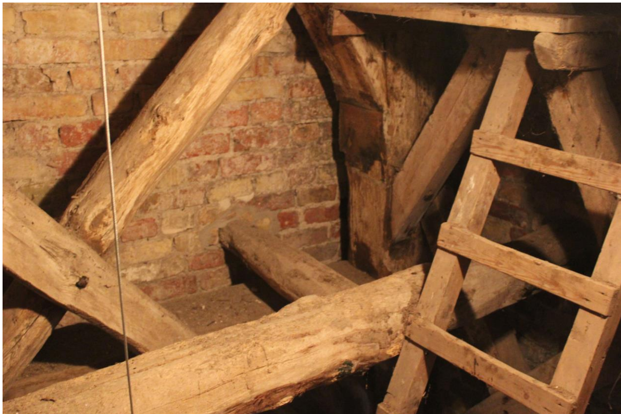
Foto 18. Een deel van de klokkenstoel op de derde verdieping. Hierop is de constructie te zien waaraan de ankers voor het muurwerk zijn gemonteerd. De balk onderin de foto is een trekbalk waaraan de korte balkjes naar de muur zijn bevestigd. Onder het korbeel is een epoxyherstelling te zien.
