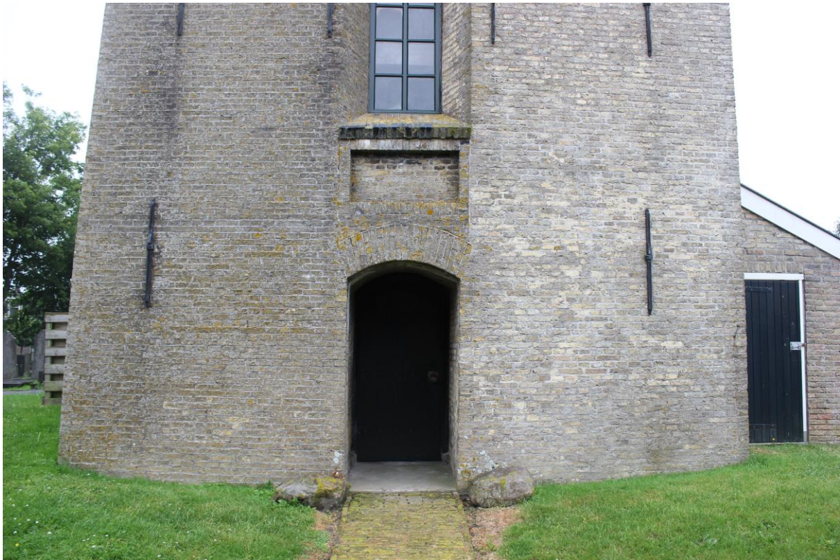
Foto 5. De ingang in de westgevel. Boven de deur is een nis gemetseld. Rechts is de deur van het baarhok zichtbaar.
