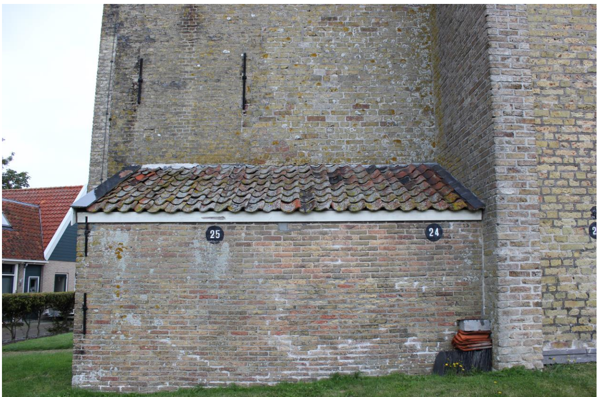
Foto 6. Tegen de zuidgevel de aanbouw. Dit is het baarhok. Het rechterdeel van het metselwerk van de toren is opgetrokken met kloostermoppen.
