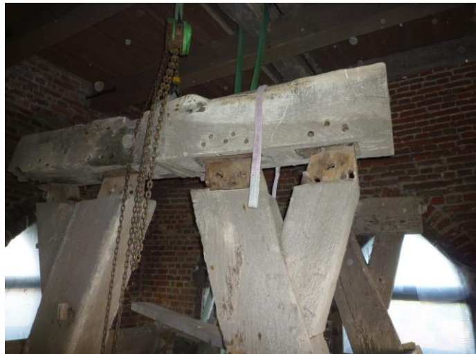
Restauratie klokkenstoel in kerktoren Pingjum
