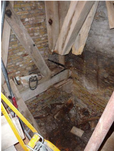
Restauratie kerktoeren Hindeloopen
