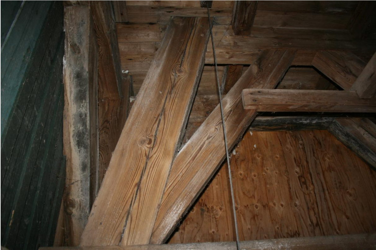
Foto 18. De schuine staander van de klokkenstoel die door de vloer van de klokkenzolder heen gaat. Helemaal links in beeld de gevelbekleding van de zuidzijde van de dakruiter. Het rechtervlak zijn de onbehandelde underlaymentplaten van de westzijde.
