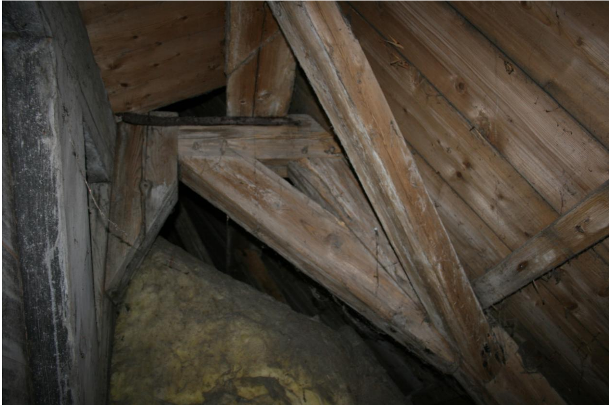
Foto 7. Het tweede kappebint gezien vanuit het westen. Links is een deel van de draagconstructie van de dakruiter te zien. Hiertegenaan is een klos gemonteerd waartegen het spantbeen met korbeel en een deel jukdekbalk is geplaatst.
