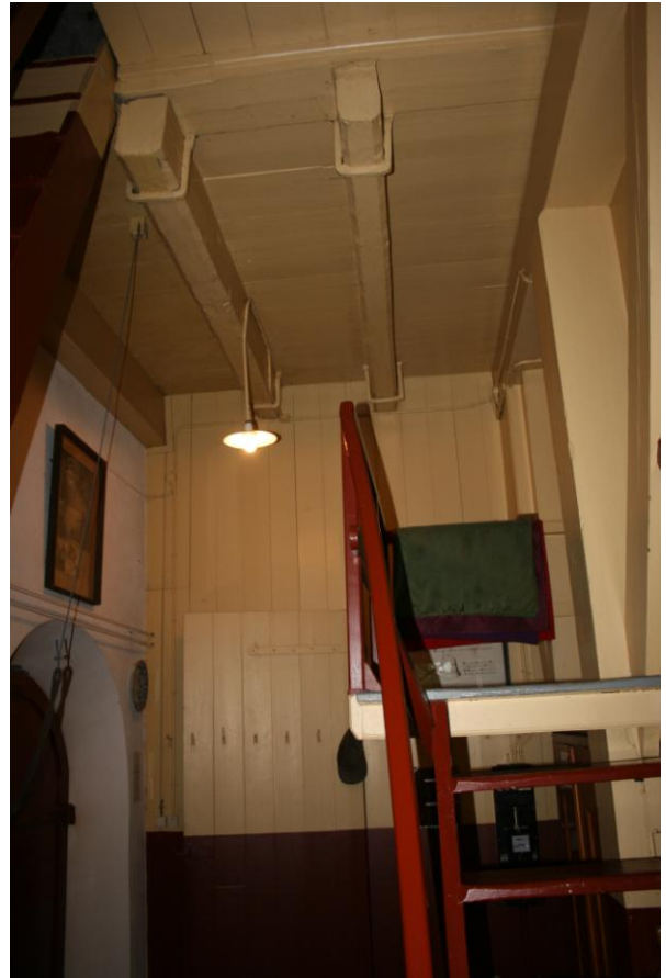
Foto 6. Zicht op het hangbalken onder de draagbalken van de torenconstructie. Links de ingang van de voorkerk in de westgevel.
