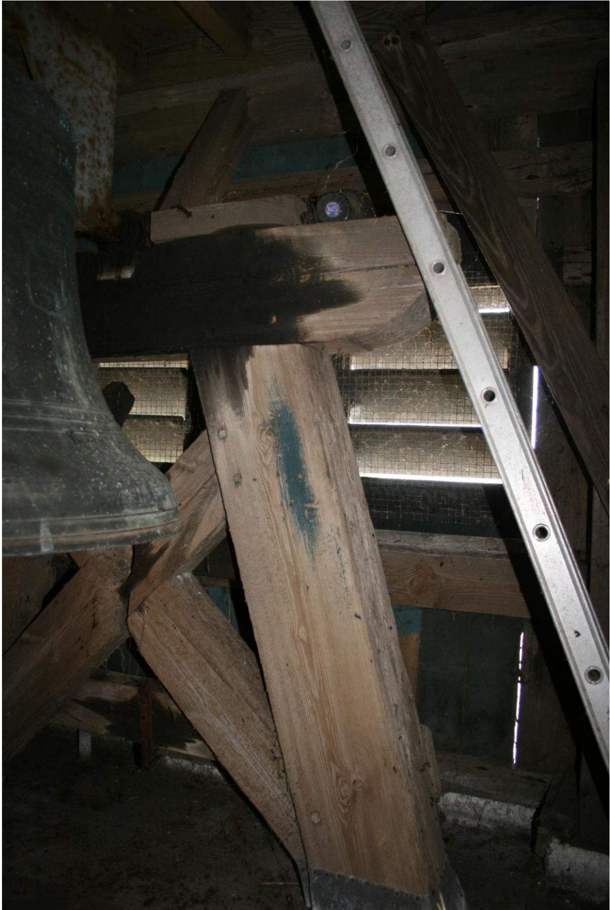
Foto 25. Het bovenste deel van de klokkenstoel met de aan de uiteinden afgeronde dekbalken. Rechts in beeld de aluminium ladder naar de spits.
