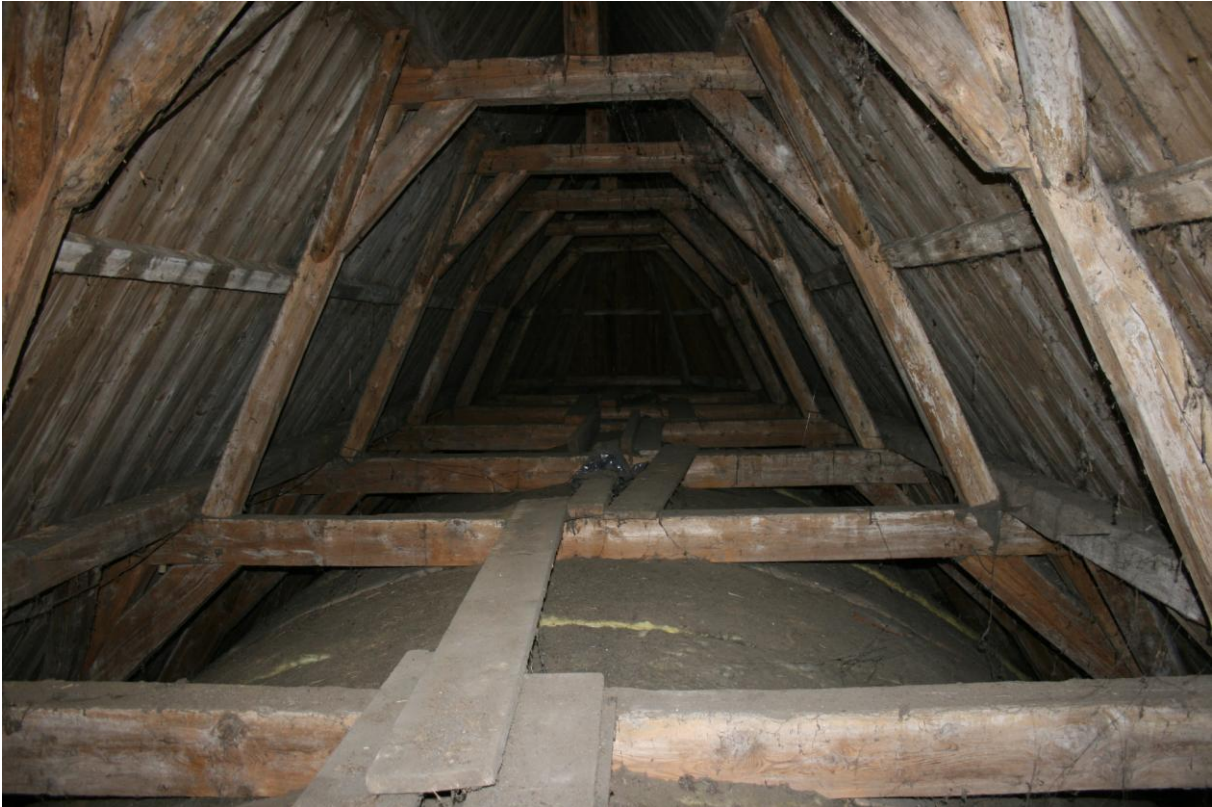
Foto 14. Foto genomen van de kapconstructie van de kerk. Men kijkt hier richting het oosten. Duidelijk zichtbaar is het losse tongewelf.
