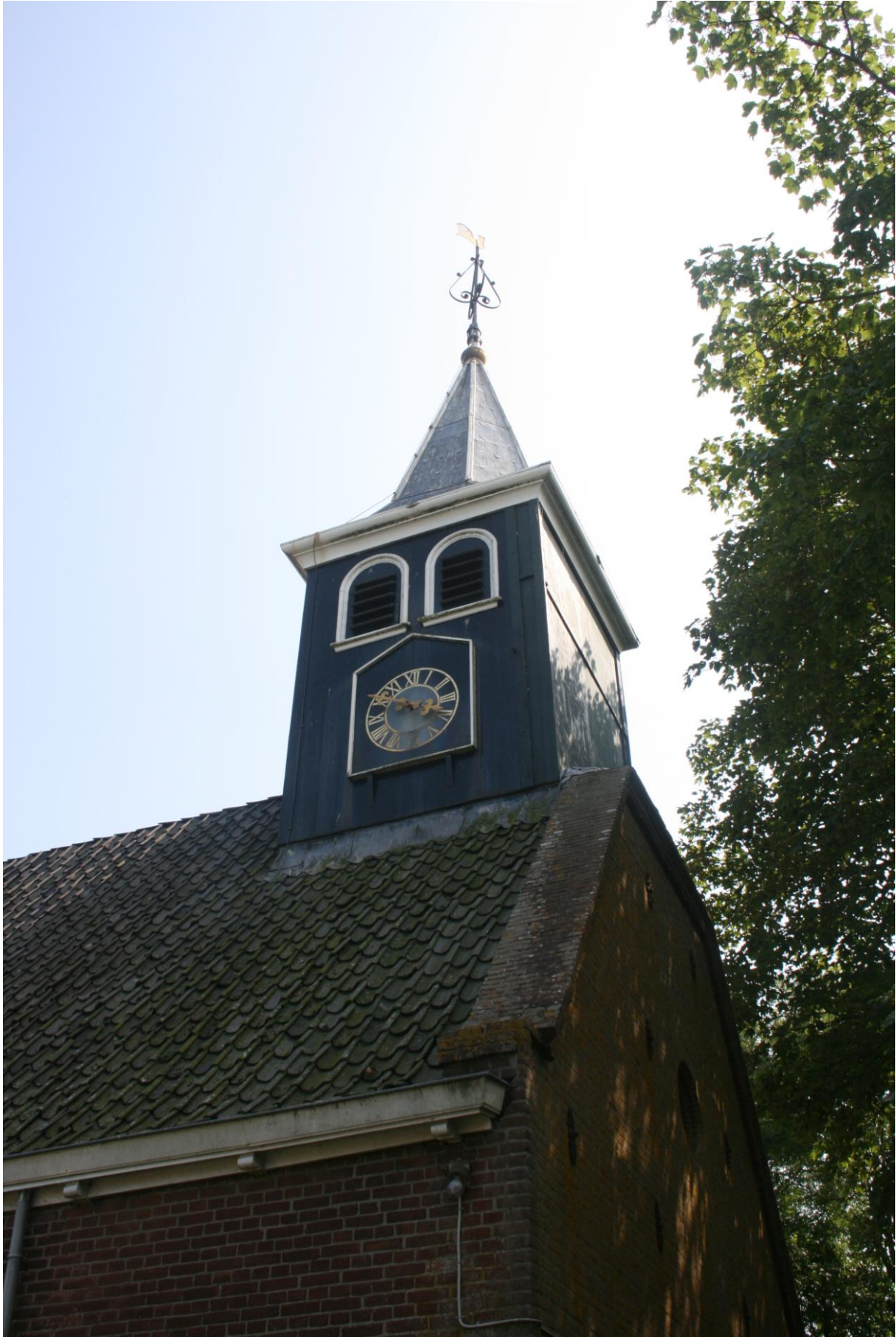
Foto 3. De westgevel met daarop de dakruiter.
