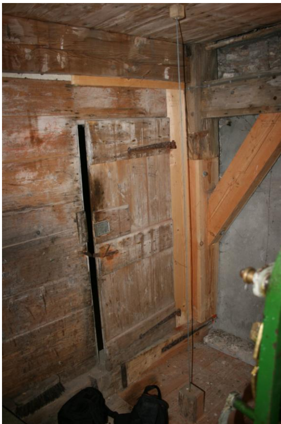
Foto 8. De ingang van de ruimte waar het uurwerk staat. Hier zijn in 2003 nog een aantal onderdelen vervangen.
