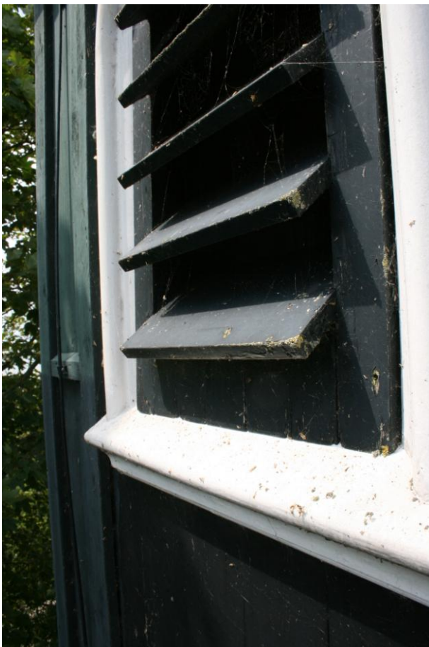
Foto 31 . De onderzijde van de galmgaten. De galmgaten staan met een raamwerk op de schuine houten lekdorpel.
