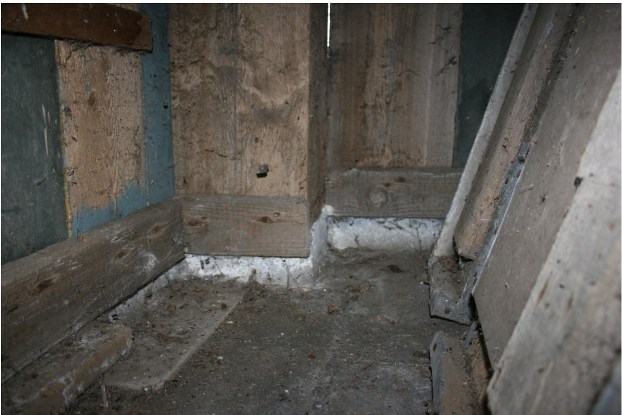
Foto 19. De zinken vloerbedekking van de klokkenzolder.
