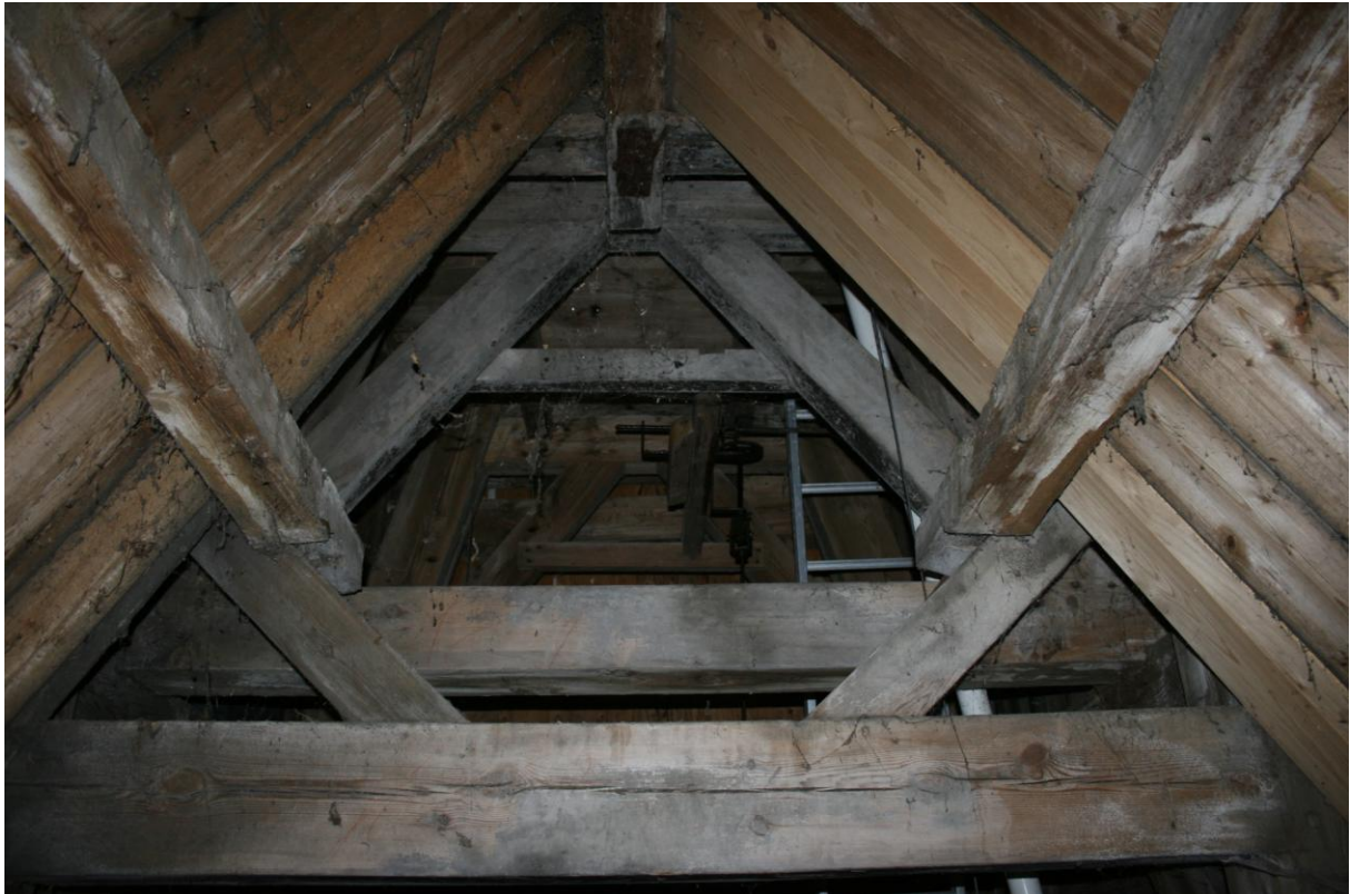
Foto 13. Foto genomen vanuit de kapconstructie van de kerk. Men kijkt hier op de voorgrond tegen de dwarsbalk C aan van foto 11. Op deze dwarsbalk staat aan weerszijden een schuin steunbalkje die de afgezaagde flieringen dragen. Achter die schuine balkjes is een draagbalk van de klokkenstoel in beeld. In het midden zijn de korbelen zichtbaar die de schuine standers van de klokkenstoel steunen.
