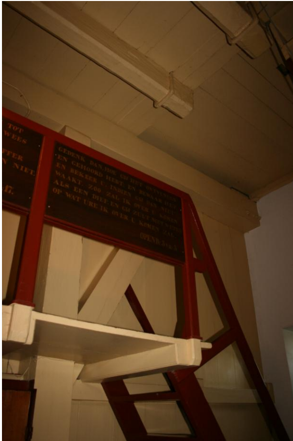
Foto 5. Achter het plateau van de orgelingang is de draagconstructie onder de trekbal op de scheiding tussen voorkerk en kerkzaal goed te zien.
