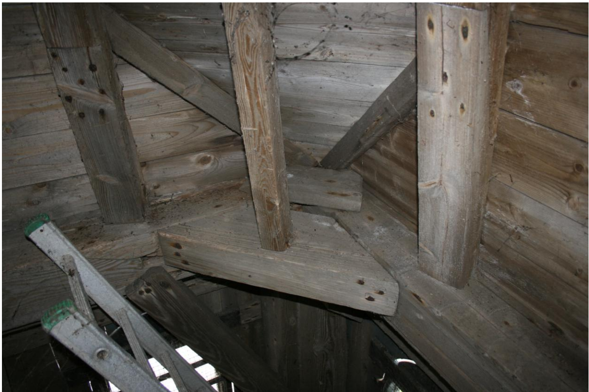
Foto 27. Het tafelment van de spits op de hoekstaander (in het trapsgat zichtbaar). De schoot van de insnoering is hier goed te zien in het midden van de foto.
