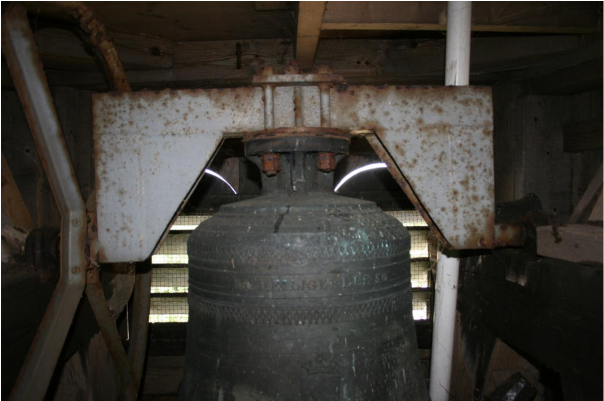
Foto 21. De stalen luibalk of ook wel luidas genoemd. Door deze krukasconstructie toe te passen ontstaat het vallende klepel principe.
