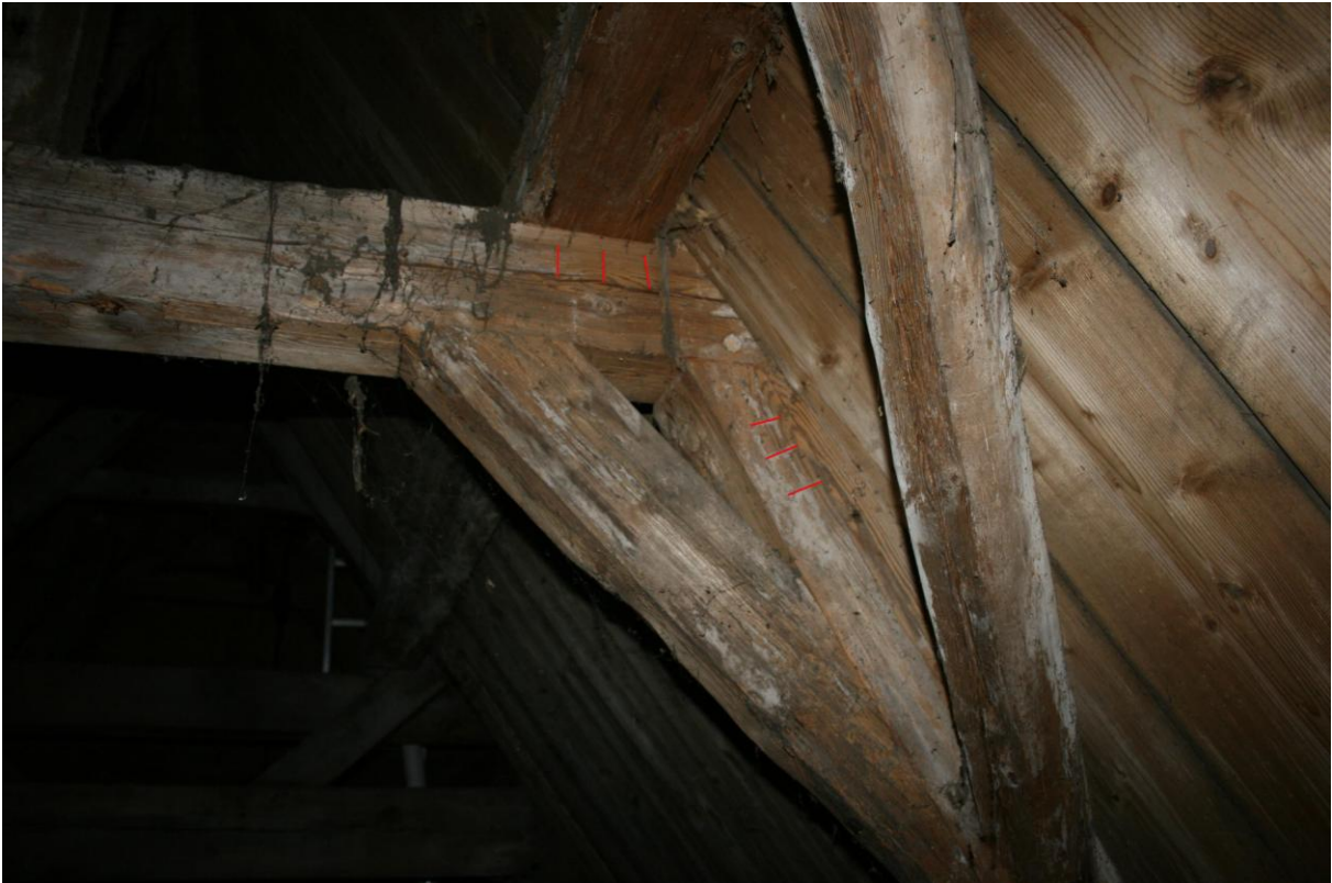
Foto 15. De telmerken zijn op de foto in rood aangegeven. Hier op de foto de Noordzijde waar rechte, gehakte merken zichtbaar zijn. Aan de zuidzijde zijn gegutste merken aanwezig.
