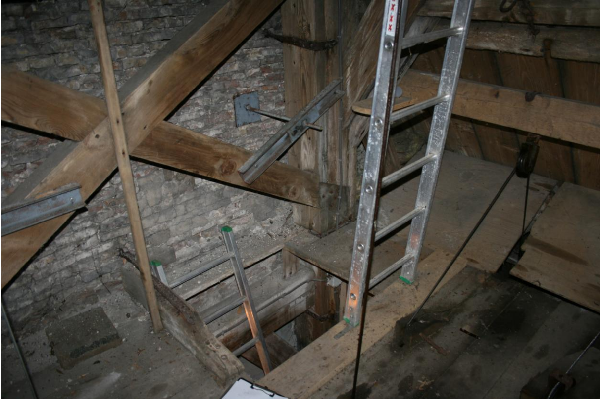
Foto 16. De tweede vloer gezien richting westgevel. Het metselwerk van de afgetopte gevel is met u-balken en draadeinden gekoppeld aan de houten constructie. Links in beeld zijn de kruisschoren die in de hoekstaanders zijn gepend. Rechts, achter de aluminium ladder is een deel van het schuine dakbeschot zichtbaar met daarboven de overgang naar de gevelbekleding van de dakruiter. Ook zichtbaar de katrol en kabels voor de gewichten van het uurwerk. De vloerdelen van deze vloer zijn 165 mm breed en 28 mm dik.
