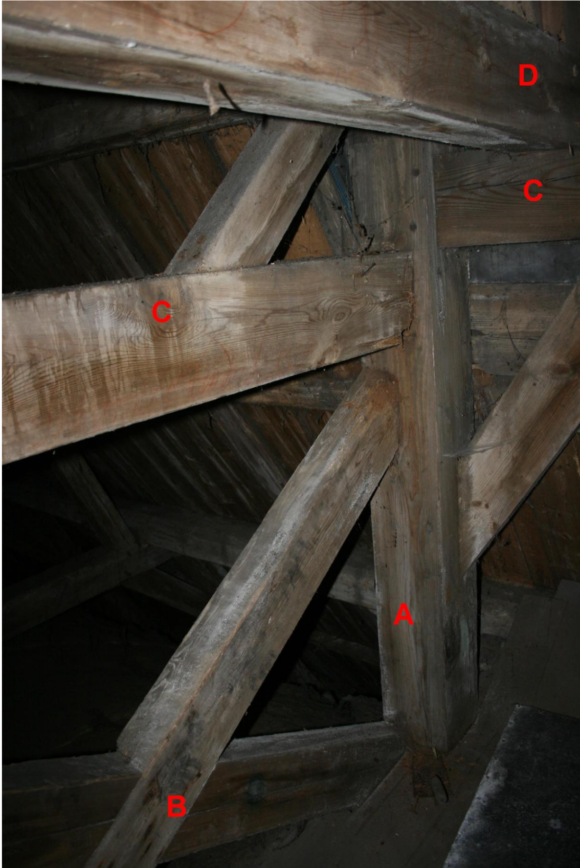
Foto 11. Een deel van de constructie van de dakruiter ter plaatse van de tweede vloer. Gezien richting zuidoost op het punt waar de dakruiter aan het kerkdak grenst. A is de hoekstaander. B is een kruisschoor tussen de hoekstaanders. C is een dwarsbalk die de hoekstaanders onderling koppelen. Hierop staat schuin een steunbalkje dat achter D langs loopt en een afgezaagde fliering ondersteund. D is een van de twee draagbalken waarop de klokkenstoel staat. Op deze draagbalk staan in rood geschreven informatie en jaartallen. Op deze foto niet leesbaar maar wel aanwezig het jaartal "1778".
