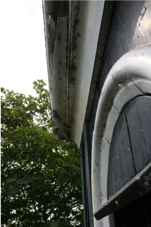
Foto 30 . De geprofileerde bovenzijde van de dakruiter en de bovenzijde van de galmgaten. Het halfronde profiel hier zichtbaar.
