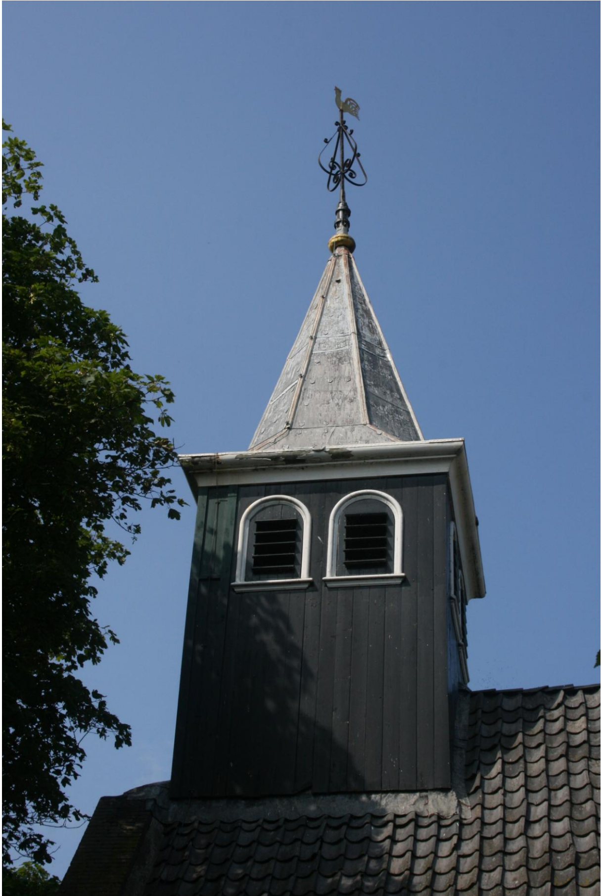
Foto 4. De zuidzijde van de dakruiter.
