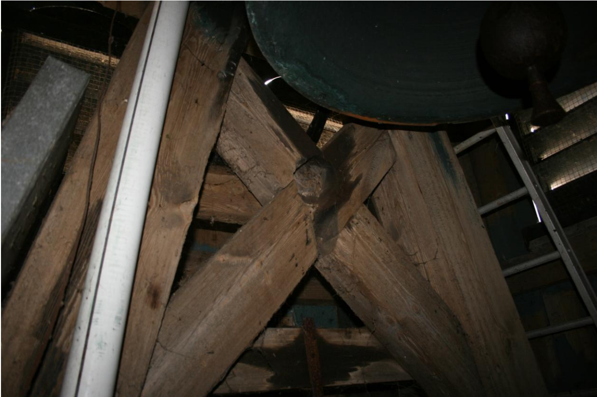
Foto 20. Vanuit het trapgat is de klokkenstoel met kruisschoren goed zichtbaar. De rand van de klok en de klepel zijn rechtsboven in beeld.
